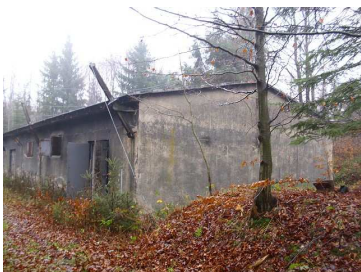
MUNA před opravou
